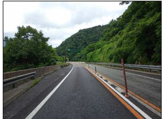
舗装補修工事 作業完了後イメージ
