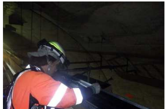
トンネル照明電源ケーブル補修作業
