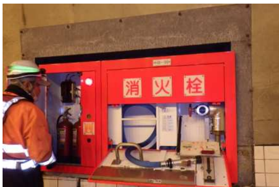
トンネル非常用設備点検
